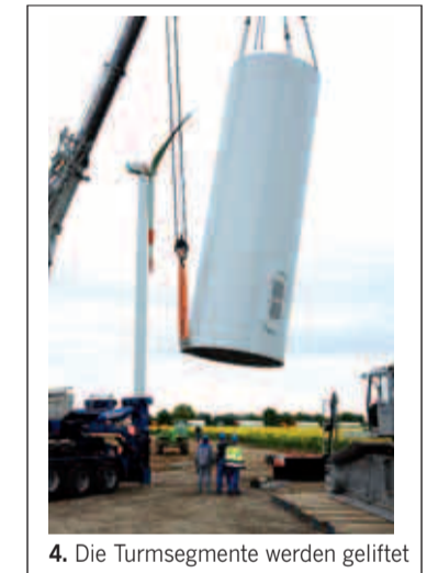
4. Die Turmsegmente werden geliftet
