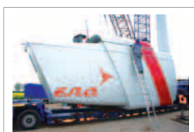
1. Anlieferung des Maschinenhauses
